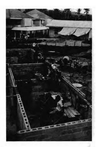
Dinding yang terbuat dari batako mendapat tekanan samping oleh angin dan gempa bumi sehingga dinding tersebut diperkuat dari dalam dengan besi beton. Penguat dengan besi itu ada beton dua macam, yaitu:
