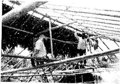
Fig. 2 Secciones de hojas levantadas a su lugar en el techo
